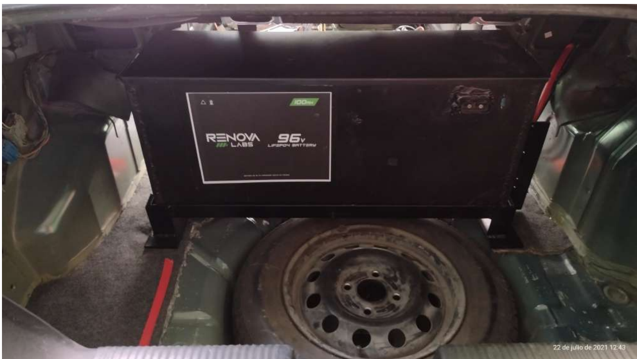
Figura 7.23: Colocación del banco de baterías sobre el soporte
